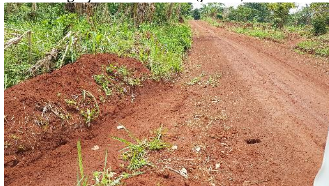
Ch. 4+200: Mitre drain provision
